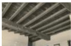
's Hertogenhoeve / zoldering (Foto 01634-01 en 02)
