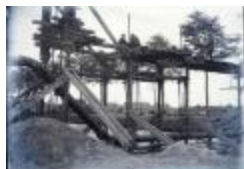
Bouwen van een brug (Glas_04_84)
