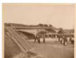
Brug over kanaal / belastingsproef (Foto 02180_01; 02180_02; 02180_03)
