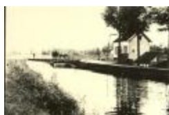
Kanaal aan brug 1 (Foto 04272_01)
