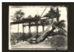
Brug leggen over het kanaal (Foto 03241_01 t.e.m. 03241_03)
