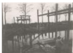
Bouwen van een kanaalbrug (Foto 05476_01; 05476_02)
