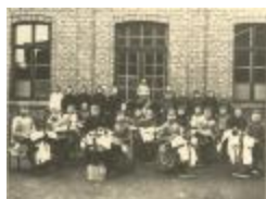
Kantschool Heilig Hart (Corbeelsstraat) (Foto 04839_01)
