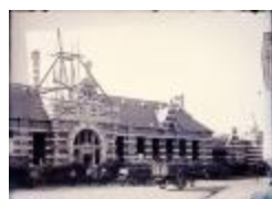
Station Turnhout / Vue de Turnhout / La gare en construction (Glas_08_02)
