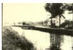
Kanaal aan brug 1 (Foto 04272_01)
