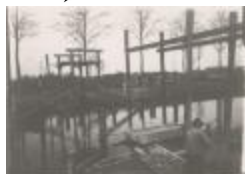
Bouwen van een kanaalbrug (Foto 05476_01; 05476_02)
