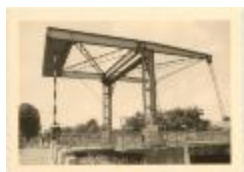
Brug 2 over het kanaal (Foto 00201_01; 00201_02)
