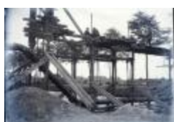
Bouwen van een brug (Glas_04_84)
