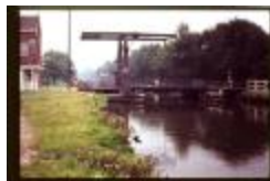
Brug I (Dia container 1_5)
