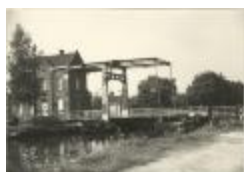
Brug 1 over de Vaart (Foto 00672_02)
