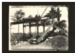
Brug leggen over het kanaal (Foto 03241_01 t.e.m. 03241_03)
