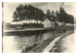
Brug 1 over het kanaal (Foto 01507-01)
