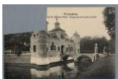
Wyneghem. Pont du château Pulle - Brug van het kasteel Pulle (Prentkaart 158_041)
