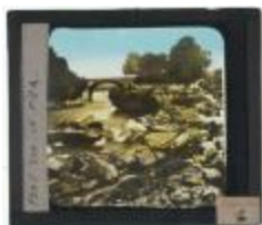
Pont sur le Fier (HH_06_000228)
