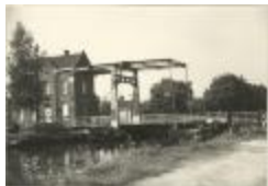
Brug 1 over de Vaart (Foto 00672_02)
