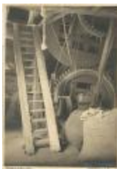
Windmolen / raderwerk van een schorsmolen (Foto 02486_01)
