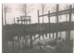
Bouwen van een kanaalbrug (Foto 05476_01; 05476_02)
