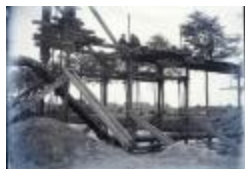
Bouwen van een brug (Glas_04_84)
