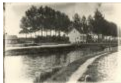
Brug 1 over het kanaal (Foto 01507-01)
