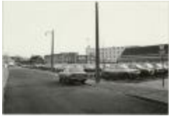
parking Muylenberg (Foto 07036-05)
