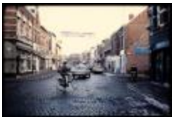
Otterstraat - Kruispunt Draaiboom voor heraanleg (Dia container 36_482)
