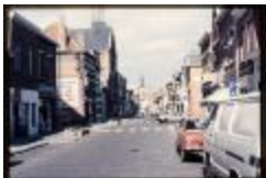
Otterstraat - Uitvleugeling - Kruispunt Draaiboomstraat (Dia container 36_487)
