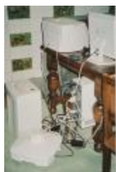
Kabinet burgemeester vóór renovatie (2002) (Foto 07196-16)
