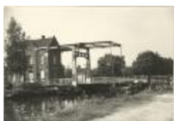
Brug 1 over de Vaart (Foto 00672_02)
