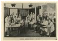
St. Julianaschool : Albertstraat / Interieur (Foto 04094_01)
