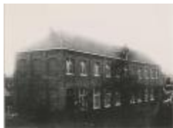
Kantschool Klinkstraat / gebouwen (Foto 05905_01; 05905_02; 05903_03; 05905_05)
