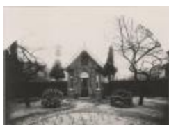
Kantschool Klinkstraat / gebouwen (Foto 05905_04)
