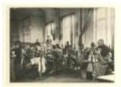
Kantschool / interieur (Foto 04161_01 en 04161_02)
