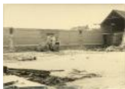
School Levensvreugde Schoolstraat / afbraak (Foto 04740_01; 04740_02 en 04740_04 t.e.m. 04740_09)
