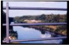
Fiets- en voetgangersbrug (Dia container 3_14)
