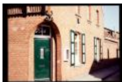
Voorgevel (Dia container 61_B65)
