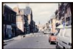
Otterstraat - Uitvleugeling - Kruispunt Draaiboomstraat (Dia container 36_487)
