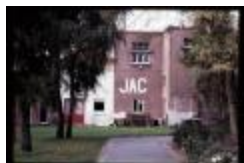
Zicht op de achterkant van de burelen van het JAC, gevestigd in de Kwakkelstraat te Turnhout. (container 31_3266)
