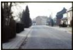
Schorvoort (Dia container 43_3106)
