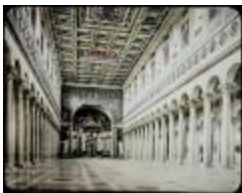
Rome: Eglise St. [P]aul: interieur (Glas1330)
