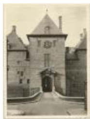
Ingangspoort kasteel (Foto 00208_01; 00208_02; 00208_05)
