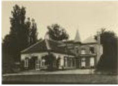
Buitengoed "Boone's Blijk" / achterkant / Heizijde (Foto 04579_01)
