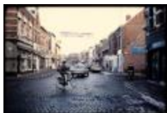
Otterstraat - Kruispunt Draaiboom voor heraanleg (Dia container 36_482)
