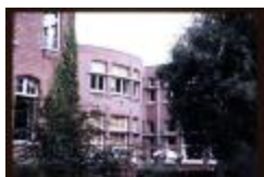
Achterbouw Stedelijk Jeugdcentrum de Wollewei (Dia container 41_3633)
