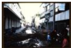
Otterstraat - Werken heraanleg (Dia's container 36_492 + 93)
