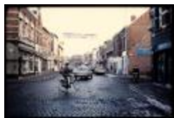
Otterstraat - Kruispunt Draaiboom voor heraanleg (Dia container 36_482)
