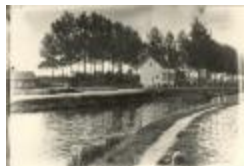
Brug 1 over het kanaal (Foto 01507-01)
