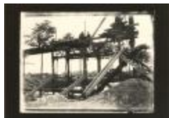
Brug leggen over het kanaal (Foto 03241_01 t.e.m. 03241_03)
