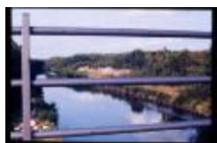
Fiets- en voetgangersbrug (Dia container 3_14)
