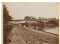
Brug met oude brug onder de boog (Foto 01080-01 en 02)
