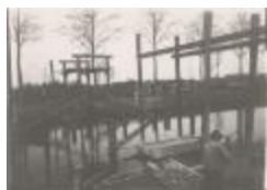
Bouwen van een kanaalbrug (Foto 05476_01; 05476_02)
