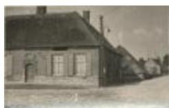
's Hertogenhoeve en schuur (Foto 01633-03 en 07)
