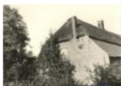
's Hertogenhoeve en schuur (Foto 01633-04 en 05)
