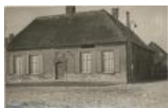
's Hertogenhoeve en schuur (Foto 01633-06 en 08)
