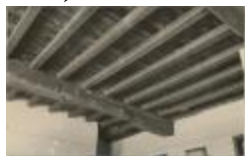
's Hertogenhoeve / zoldering (Foto 01634-01 en 02)
