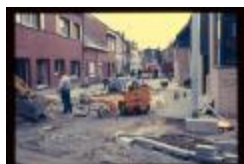
Heraanleg (Dia container 61_B34)
