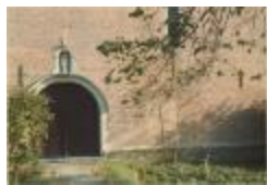
Priorij Korsendonk / exterieur : Poort en muurankers "1631" (Foto 04679_01)
