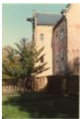
Priorij Korsendonk / exterieur : westgevel (Foto 04671_01)
