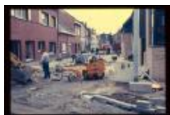
Heraanleg (Dia container 61_B34)
