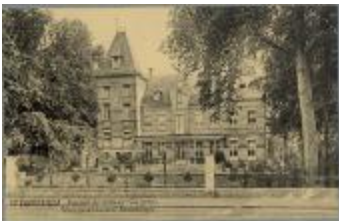
Wyneghem Façade du château "La grue" Voorgevel kasteel Kroonvogel (Prentkaart 158_044)
