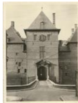
Ingangspoort kasteel (Foto 00208_01; 00208_02; 00208_05)
