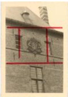
Detail gevel kasteel (Foto 00203_01)
