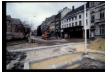
Dia met zicht op de heraanleg van de Grote Markt te Turnhout. Met de inmiddels afgebroken gebouwen van het Kursaal en het postgebouw. (container 37_3498)
