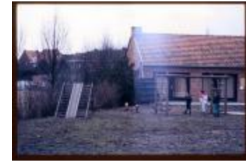
Brug I (Dia container 11_1148)
