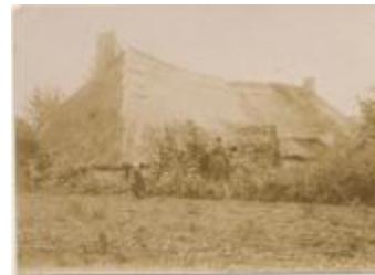
Oude Kempische schuur (strooien dak tot tegen grond) (Foto 01267_01 en 02)
