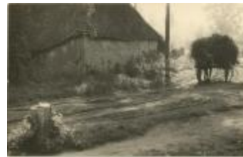
Hoeve / lemen schuur met vlechtwerk (Foto 04035_01)
