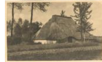
Oude Schuur (Sto dak) nabij de watermolen (Foto 00430-01 en 02 en 03)
