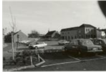
Parking Muylenberg (Foto 07034-10)
