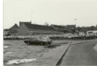
Parking Muylenberg (Foto 07036-10)
