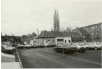
parking Muylenberg (Foto 07036-07)
