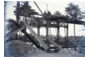
Bouwen van een brug (Glas_04_84)
