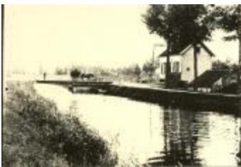
Kanaal aan brug 1 (Foto 04272_01)
