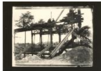
Brug leggen over het kanaal (Foto 03241_01 t.e.m. 03241_03)
