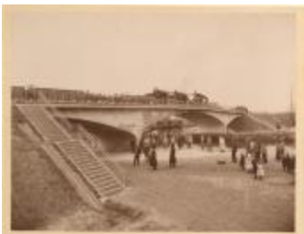
Brug over kanaal / belastingsproef (Foto 02180_01; 02180_02; 02180_03)
