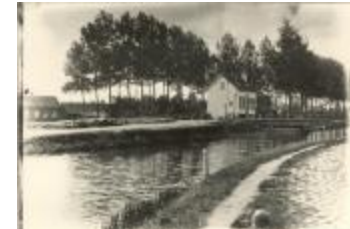
Brug 1 over het kanaal (Foto 01507-01)
