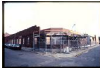
Bouw (Dia container 27_4053)
