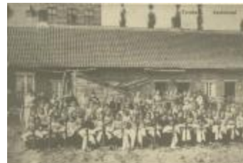
Kantschool in de Tien Geboden (Apostoliekenschool) (Foto 04837_01)
