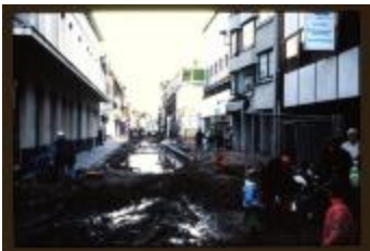
Otterstraat - Werken heraanleg (Dia's container 36_492 + 93)
