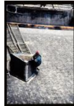
Herstelwerken (Dia container 43_3099)
