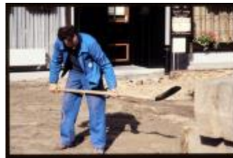
Wegwerkzaamheden (Dia container 38_3458)
