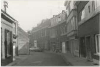
Driezenstraat / heraanleg (Foto 07029-02)
