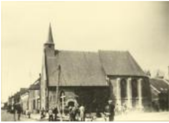
Oprichten van elektriciteitspaal aan Theobalduskapel (Foto 05037_01; 05037_02)
