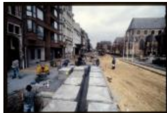
Heraanleg (Dia container 38_3435)
