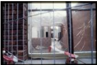
Verbouwwerken (Dia container 38_3421)
