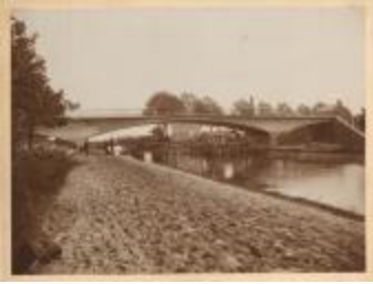
Brug met oude brug onder de boog (Foto 01080-01 en 02)
