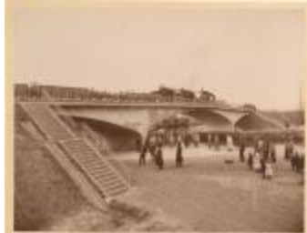
Brug over kanaal / belastingsproef (Foto 02180_01; 02180_02; 02180_03)
