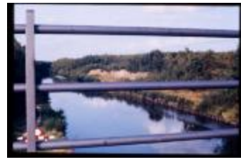
Fiets- en voetgangersbrug (Dia container 3_14)
