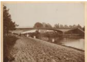
Brug met oude brug onder de boog (Foto 01080-01 en 02)
