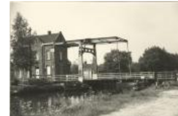
Brug 1 over de Vaart (Foto 00672_02)
