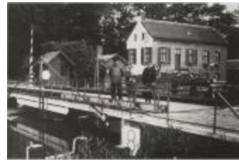
Brugwachtershuis aan brug 8 (Meirgoren) (Foto 05825_01)
