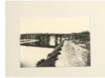
Bouw van de brug over kanaal (foto 03793_01 en 03793_02)
