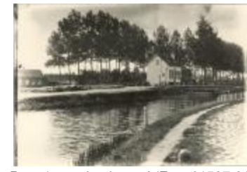
Brug 1 over het kanaal (Foto 01507-01)
