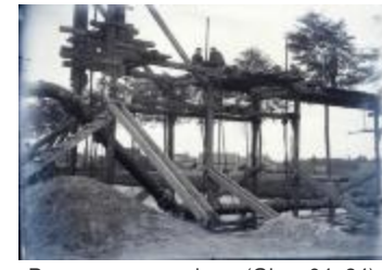
Bouwen van een brug (Glas_04_84)
