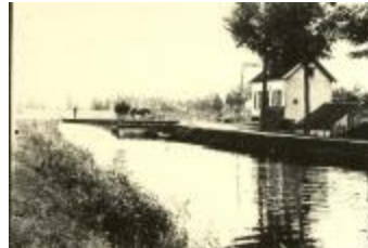
Kanaal aan brug 1 (Foto 04272_01)
