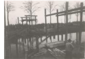
Bouwen van een kanaalbrug (Foto 05476_01; 05476_02)
