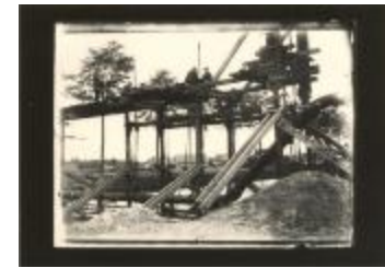
Brug leggen over het kanaal (Foto 03241_01 t.e.m. 03241_03)
