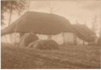
Oude schuur met strooien dak en oud schob (uit zoden) (Foto 00688-01 en 02)
