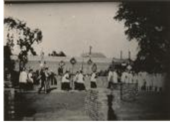
O.L. Vrouw Middelareskerk: eerste steenlegging (Foto 03210_01 t.e.m. 03210_04)
