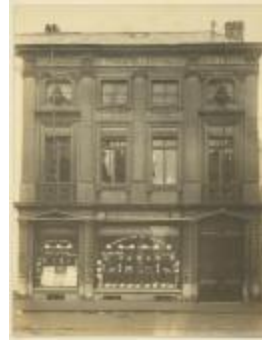
Gasthuisstraat / gevel (Foto 04224_01)
