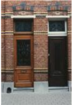
Gevels Otterstraat (Foto 00483_08)
