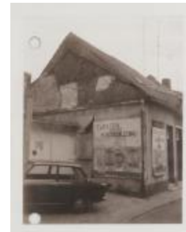
Korte Begijnenstraat / gevels / afgebroken (Foto 06552-22)
