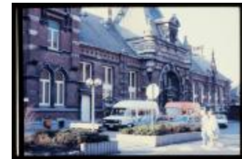
Voorgevel (Dia's container 17_2676 + 2685)
