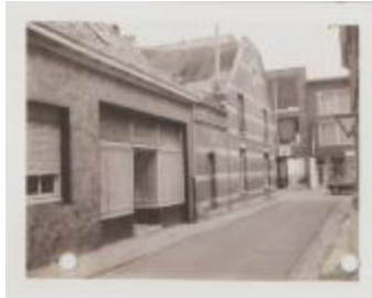
Korte Begijnenstraat / gevels / afgebroken (Foto 06552-24)
