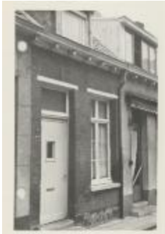
Korte Begijnenstraat / gevels / afgebroken (Foto 06552-08)
