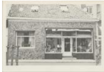
Korte Begijnenstraat / gevels / afgebroken (Foto 06552-02)
