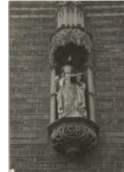
Gevelbeeld St. Lucia / Herentalsstr. (Foto 06399-03)
