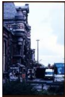
Voorgevel (Dia's container 17_2592 + 2672)
