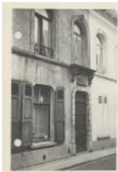
Korte Begijnenstraat / gevels / afgebroken (Foto 06552-19)
