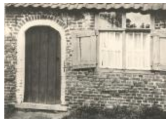
Hoeve op weg Retie-Postel / gevelgedeelte (Foto 02859_01)
