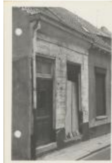
Korte Begijnenstraat / gevels / afgebroken (Foto 06552-13)
