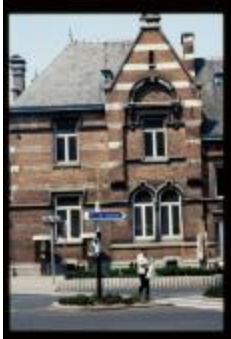
Voorgevel (Dia container 20_2237)
