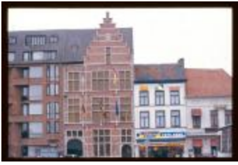
Voorgevel (Dia's container 58_20 + 28)
