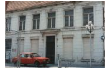
Gevels Otterstraat (Foto 00483_05)
