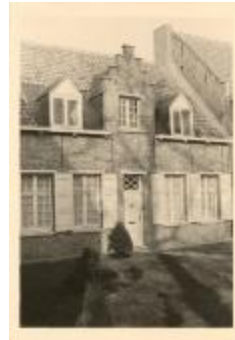
Begijnhof: gevel (Foto 03162_01)
