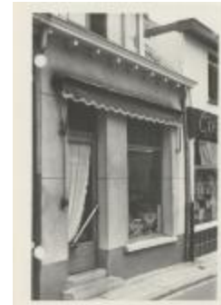
Korte Begijnenstraat / gevels / afgebroken (Foto 06552-06)
