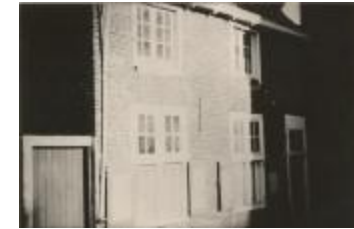
Begijnhof: gevel (Foto 03197_01)
