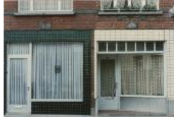
Gevels Otterstraat (Foto 00483_11)
