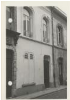
Korte Begijnenstraat / gevels / afgebroken (Foto 06552-16)
