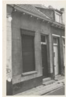
Korte Begijnenstraat / gevels / afgebroken (Foto 06552-09)
