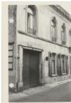
Korte Begijnenstraat / gevels / afgebroken (Foto 06552-20)
