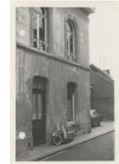
Korte Begijnenstraat / gevels / afgebroken (Foto 06552-15)
