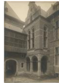
Binnenkoer van het kasteel (Foto 00202_06; 00202_08)
