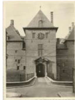
Ingangspoort kasteel (Foto 00208_01; 00208_02; 00208_05)
