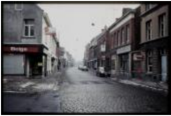
Otterstraat - Hoek Klinkstraat (Dia's container 36_464 + 65)
