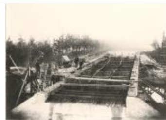
Leggen van een brug over een kanaal (foto 01396-01)
