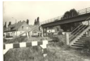
Voetgangers/fietsbrug over de Vaart (Foto 00672_01; 05222_01)
