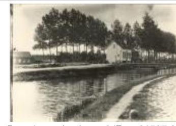
Brug 1 over het kanaal (Foto 01507-01)
