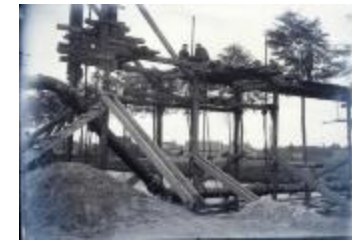
Bouwen van een brug (Glas_04_84)
