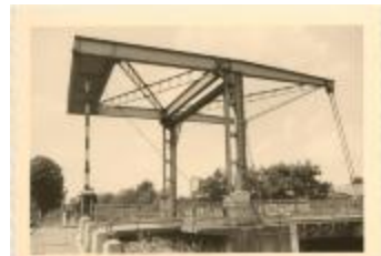
Brug 2 over het kanaal (Foto 00201_01; 00201_02)
