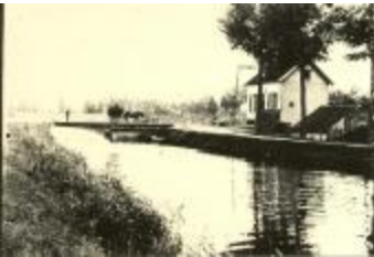
Kanaal aan brug 1 (Foto 04272_01)
