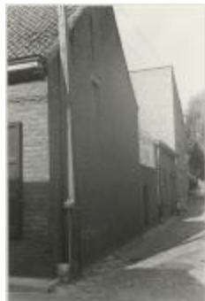
Driezenstraat / heraanleg (Foto 07030-10)
