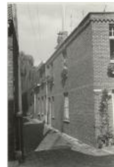
Driezenstraat / heraanleg (Foto 07030-12)
