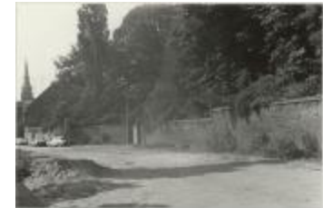
Driezenstraat / heraanleg (Foto 07030-04)
