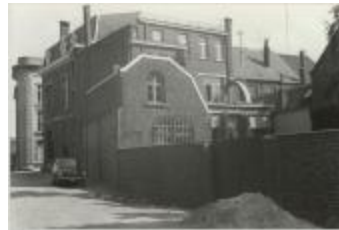
Driezenstraat / heraanleg (Foto 07030-07)
