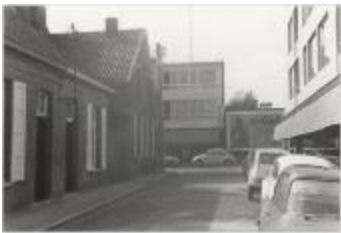
Driezenstraat / heraanleg (Foto 07029-01)
