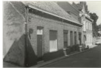
Driezenstraat / heraanleg (Foto 07030-03)
