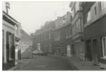
Driezenstraat / heraanleg (Foto 07029-02)
