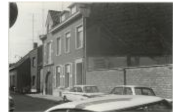
Driezenstraat / heraanleg (Foto 07030-08)
