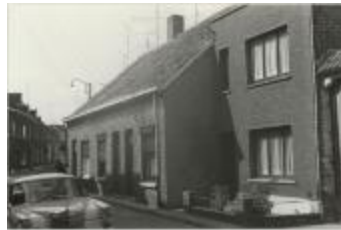
Driezenstraat / heraanleg (Foto 07030-06)
