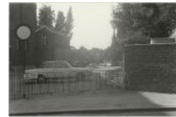
Driezenstraat / heraanleg (Foto 07029-04)
