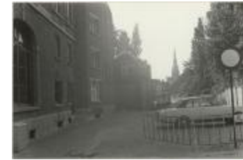
Driezenstraat / heraanleg (Foto 07029-08)
