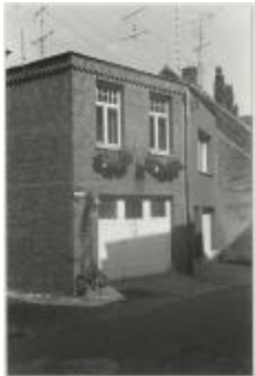
Driezenstraat / heraanleg (Foto 07030-01)
