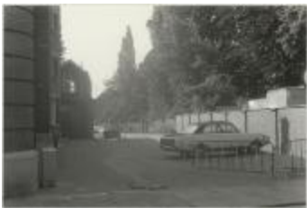
Driezenstraat / heraanleg (Foto 07029-09)
