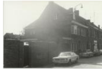
Driezenstraat / heraanleg (Foto 07029-07)
