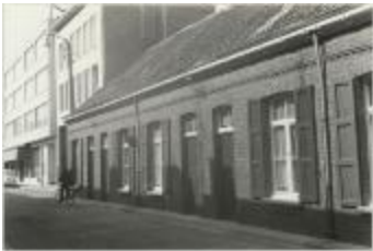
Driezenstraat / heraanleg (Foto 07030-05)
