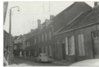
Driezenstraat / heraanleg (Foto 07029-03)
