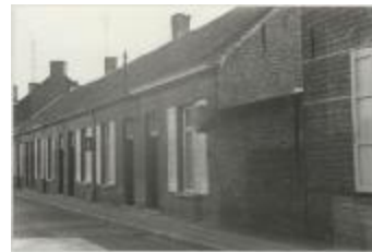
Driezenstraat / heraanleg (Foto 07029-11)
