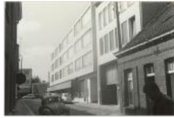
Driezenstraat / heraanleg (Foto 07029-06)
