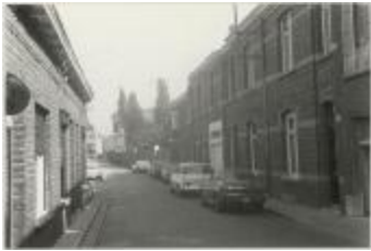
Driezenstraat / heraanleg (Foto 07029-05)
