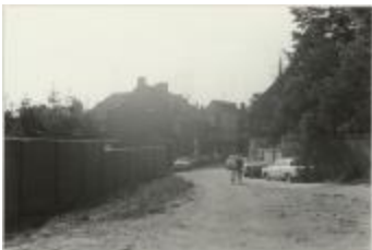
Driezenstraat / heraanleg (Foto 07030-09)
