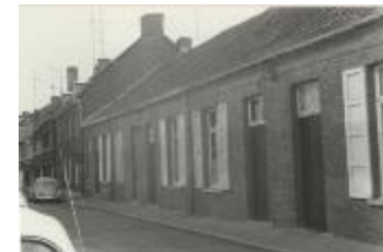
Driezenstraat / heraanleg (Foto 07029-12)
