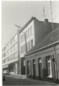
Driezenstraat / heraanleg (Foto 07030-02)
