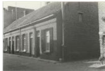
Driezenstraat / heraanleg (Foto 07030-11)
