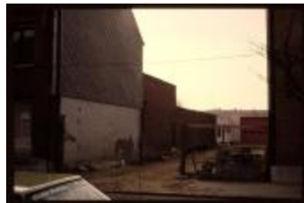
Achterliggend gebouw (container 39_245)
