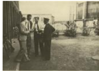
Gasfabriek Koningin Elisabethlei - exterieur - binnenkoer (Foto 05027_01)
