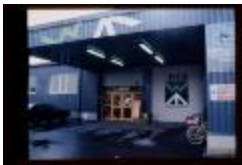
Ingang (Dia container 60_13)
