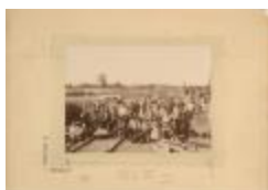
Spoorbrug en spoorwegarbeiders - zicht naar Nederland (Foto 01284_01)
