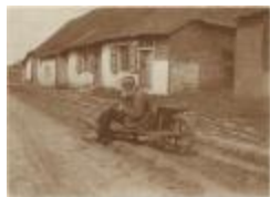
Kempische hoeve (woonhuis en schuur onder 1 dak) (Foto 01884_01 tem 03)
