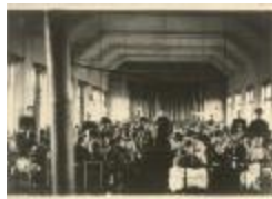
Kantschool Klinkstraat / interieur klassen (Foto 04841_01 t.e.m. 04841_05)
