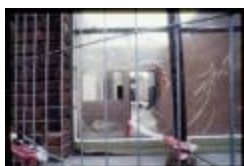
Verbouwwerken (Dia container 38_3421)
