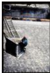
Herstelwerken (Dia container 43_3099)
