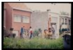
Arbeiders (Dia container 12_1219)
