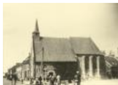
Oprichten van electriciteitspaal aan Theobalduskapel (Foto 05037_01; 05037_02)
