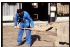
Wegwerkzaamheden (Dia container 38_3458)
