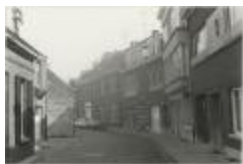
Driezenstraat / heraanleg (Foto 07029-02)
