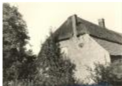
's Hertogenhoeve en schuur (Foto 01633-04 en 05)
