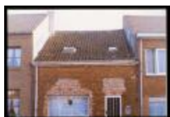
Gevel (Dia container 5_2452)
