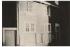
Begijnhof: gevel (Foto 03197_01)
