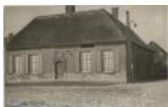
's Hertogenhoeve en schuur (Foto 01633-06 en 08)
