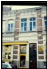
Verkrotting (Dia container 16_1797)
