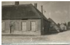
's Hertogenhoeve en schuur (Foto 01633-03 en 07)
