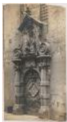
Deur van hospitaal in Nieuwstraat vóór restauratie (Foto FG-076)
