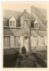
Begijnhof: gevel (Foto 03162_01)
